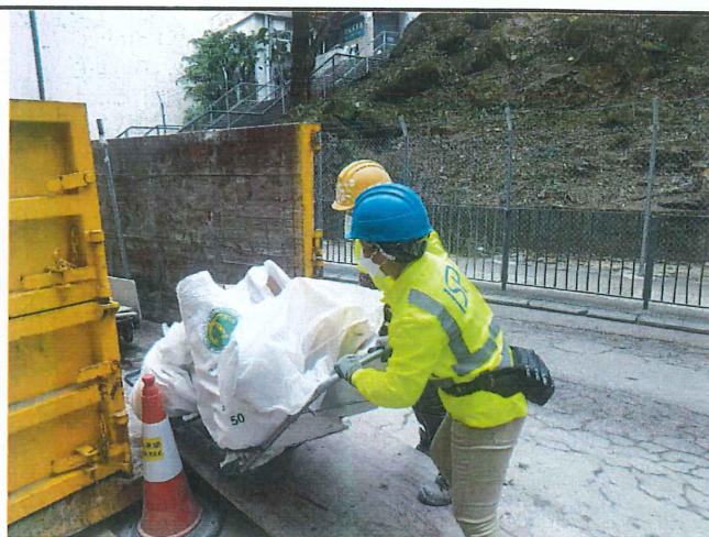
12.保持工地整理
