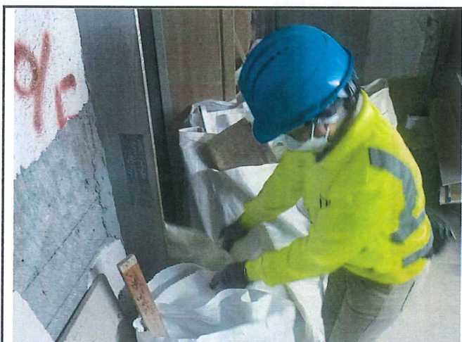
11.保持工地整理
