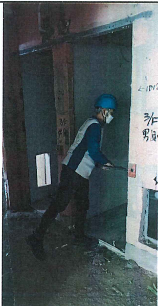
13.加強巡視工地(防鼠)
