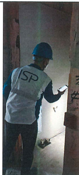
14. 加強巡視工地(防鼠)
