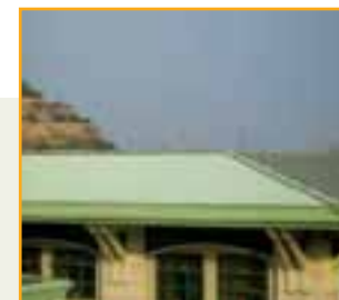
非吸熱屋頂 — 利用淺色或反光薄膜覆蓋屋頂減少吸熱
