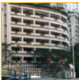
樓宇下的多層停車場
