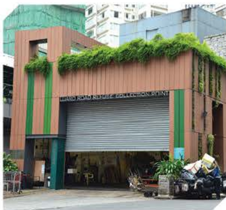
現有位於市區的垃圾收集站
