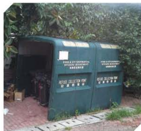
現有位於郊外地區的垃圾收集站
